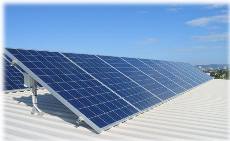
شکل 3- زاویه ی استقرار و نحوه قرارگیری پنل های فتولتائیک
